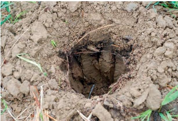
Abbildung 70: Aufrauen der Bohrlochwand
