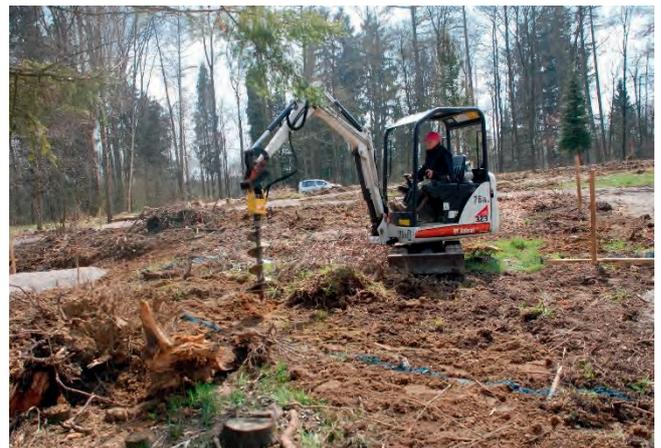
Abbildung 67: Lochbohrung mit Kleinbagger
