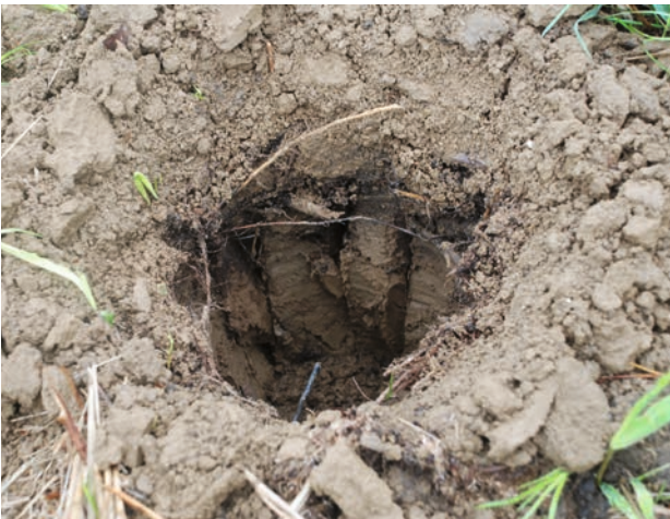
Abb. 34 Aufrauen der Bohrlochwand
