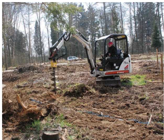
Abb. 31 Lochbohrung mit Kleinbagger
