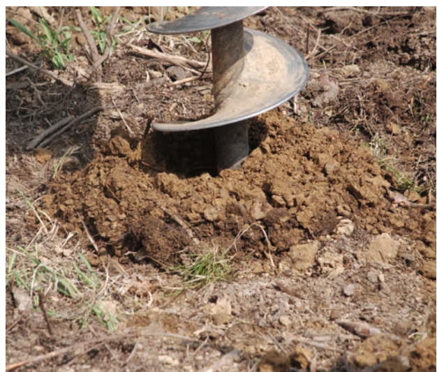
Abb. 32 Bohrspindel mit 30 cm Durchmesser
